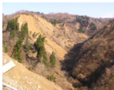
写真-2 寺野下流における深層崩壊（11月26日撮影）
