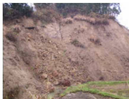
写真-1 小松倉地区における表層崩壊（11月25日撮影）
