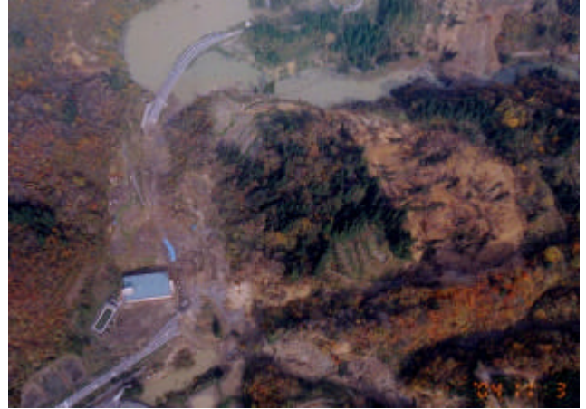
写真 2 東竹沢地すべり平面写真 国道291号線に並行した芋川の流路が写真右手から崩落した地すべり土塊により閉塞した。 (2004年11月3日撮影)
