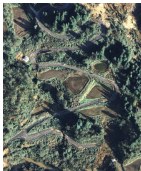
写真-7 亀裂が多数発生している斜面(10月24日撮影)
