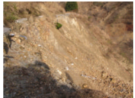
写真-4 寺野下流の道路盛土斜面の崩壊状況(11月26日撮影)
