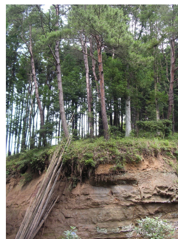
写真5 崩壊斜面上部で倒れかかっている木
