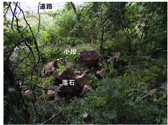
写真6 盛土された小段が落石を止めた例
