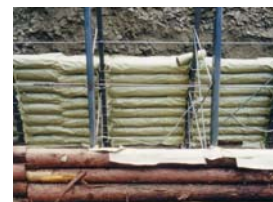
写真-2 漏れ防止材貼付
