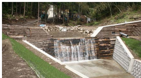
写真-5 熊本県 阿蘇地域振興局 復旧治山工事楯平1号
