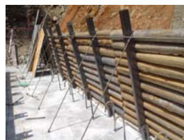
写真-1 組立全景
