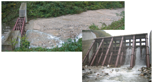
写真2 土石流捕捉事例 (菅沼谷第1えん堤)
