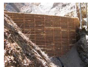
写真-3 壁面のバリエーション(左：緑化、右：間伐材)
