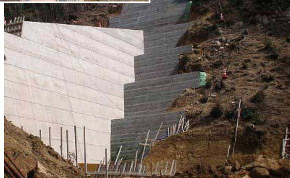
写真-1 間詰擁壁
