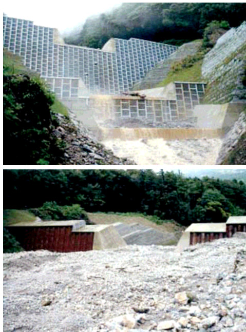
三重県 桑名建設事務所 西ノ貝戸川
