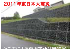
かご工による復旧箇所は無被害
