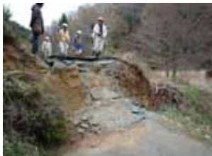
最大段差約1.8mの発生位置
