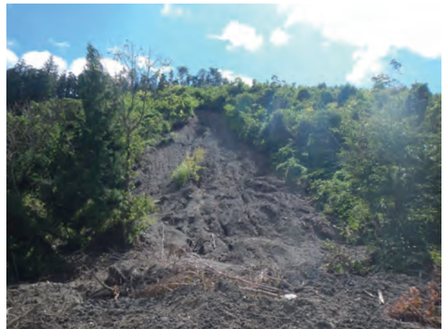
写真-8 崩壊地の状況
