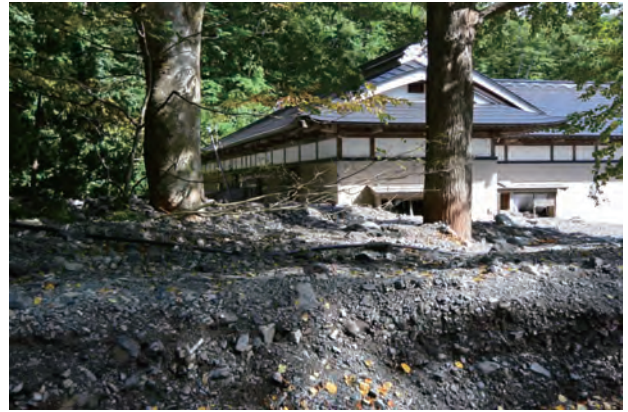
写真-21 被災人家周囲を覆う礫径の小さい土砂の堆積と建物・樹木の状況
