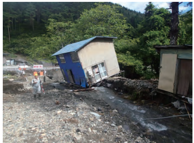
写真-1 侵食により傾斜した倉庫(合流点付近)
