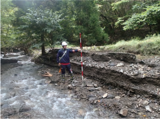
写真-2 土砂堆積状況 (谷出口上流側)
