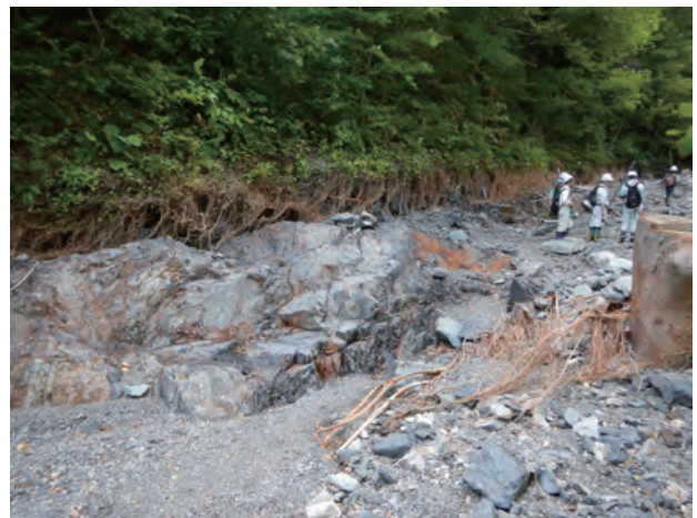
写真-22 坂本川に沿う土砂氾濫と溪岸侵食の状況（流水の侵食でえぐられ、根だけ残った溪岸）
