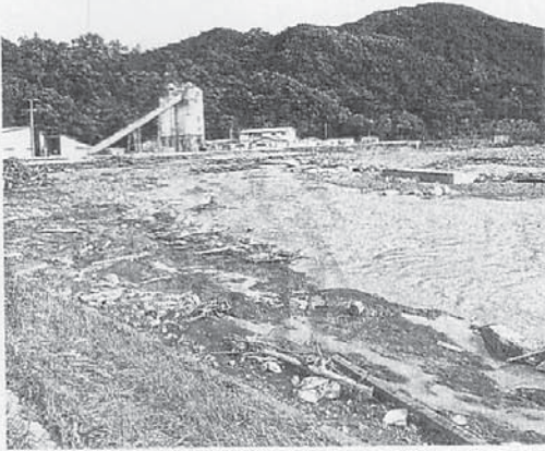
岩手町の小本川の河床には大量の土砂堆積が確認された（井良沢教授提供）
