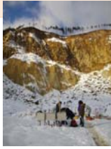
荒砥沢滑落崖直下に設置した気象・水文観測装置
