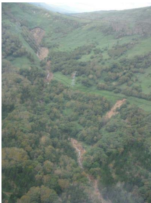
写真 3-1. 尾根部に近い斜面での崩壊
