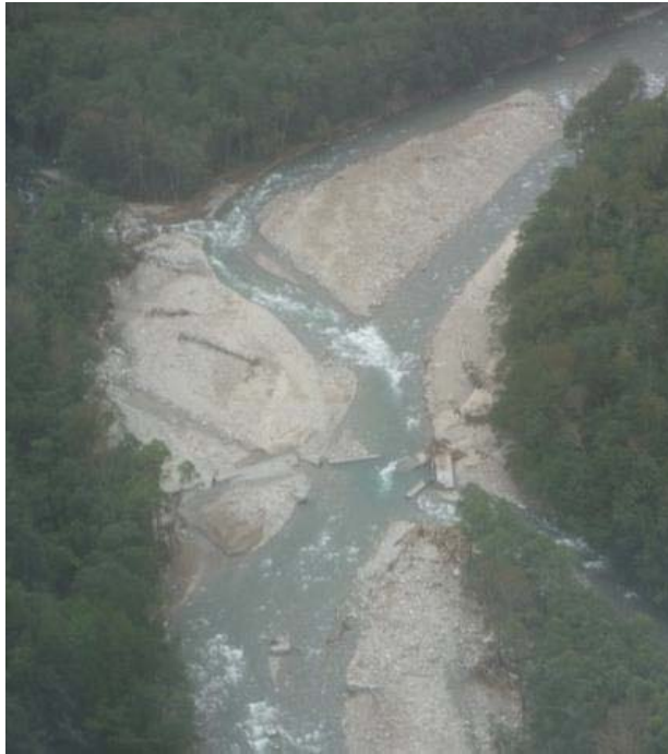
写真 1-5. 破壊されたオピリネツプ沢直下の治山堰堤
