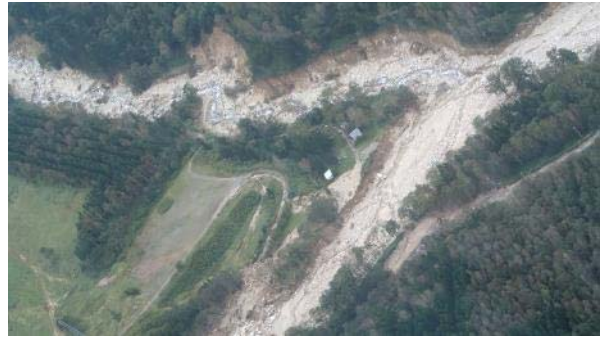
写真 2-4. 中流部の溪岸侵食
