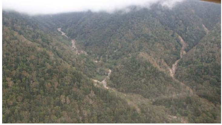
写真 1-2. 第 8 号堰堤より上流部
