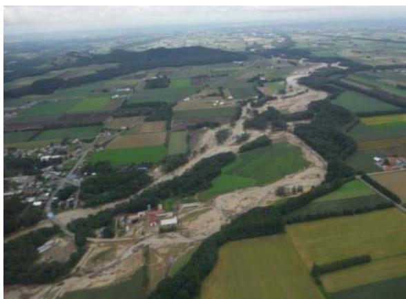
写真 1-8. 下流部での滯筋の蛇行と河岸への氾濫
