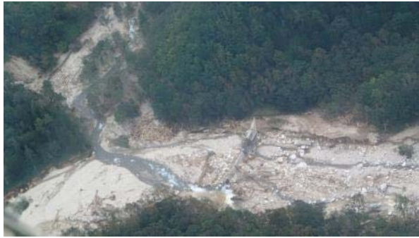
写真 2-3.第 1 号砂防堰堤
