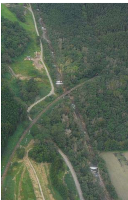
写真 3-3. 落差工と護岸による溪流保全工
