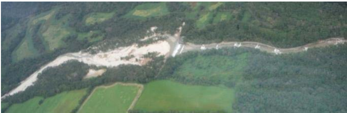
写真 2-5.第 2 号砂防堰堤
