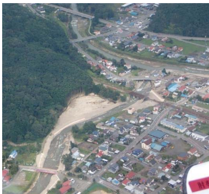
写真 3-4. 新得駅付近での氾濫
