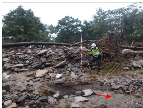
写真15 九号川上流部の土砂堆積状況
