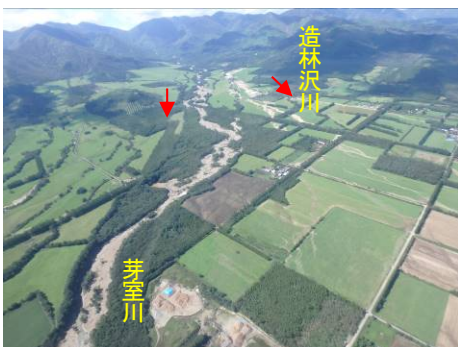
写真 j 芽室川の蛇行による側岸侵食 と造林沢川の土石流の氾濫 （上羽帯地区付近）
