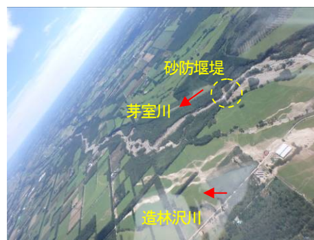
写真 k 砂防堰堤による土石流の捕捉 ・土砂の調節・流路の規制（流路の拡散防止）
