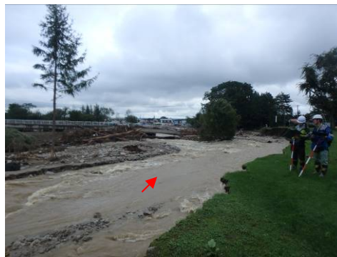
写真13 石山橋下流での右岸側の側岸侵食、石山橋の下流のペケレベツ橋（下流）の落橋
