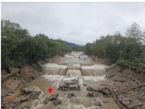
写真8 2号砂防ダム下流の溪流保全工
