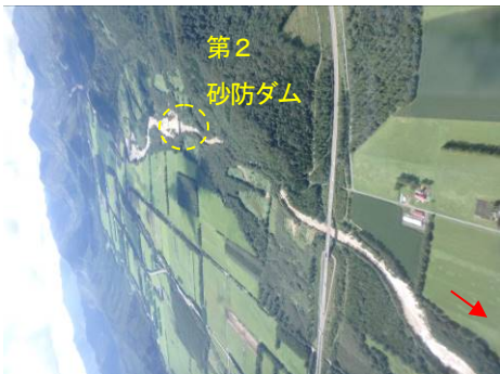
写真 g 砂防堰堤による土石流の捕捉・土砂の調節、下流の溪流保全工の状況
