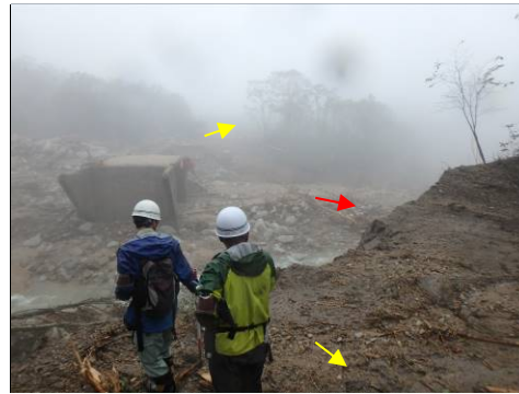
写真2 旧日勝スキー場に向かう道路への土砂流出 (黄色矢印が土砂流出の方向)
