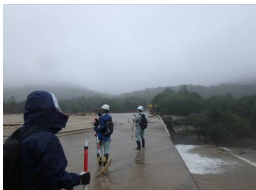
現地調査状況（ペケレベツ川第 2 砂防ダム）
